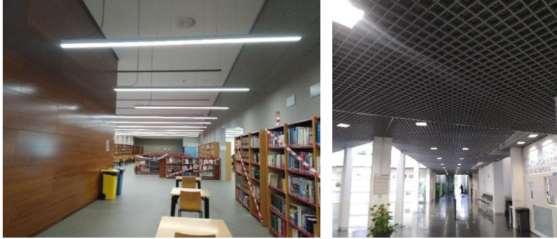
Ilustración 19. Renovación da iluminación na biblioteca central (esquerda) e na EEL, sede campus (dereita)
